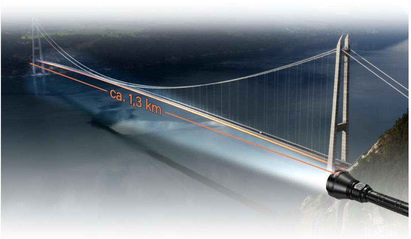
Hardangerbrua Brücke / Norwegen
